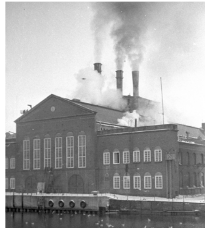
Elektrociepłownia na Ołowiance w Gdańsku.
