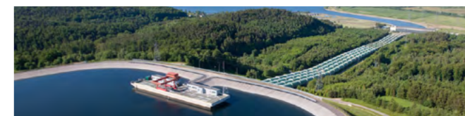
Elektrownia wykorzystuje do pracy spiętrzone wody Jeziora Żarnowieckiego (zbiornik dolny) oraz sztucznie magazynowane w zbiorniku górnym.
