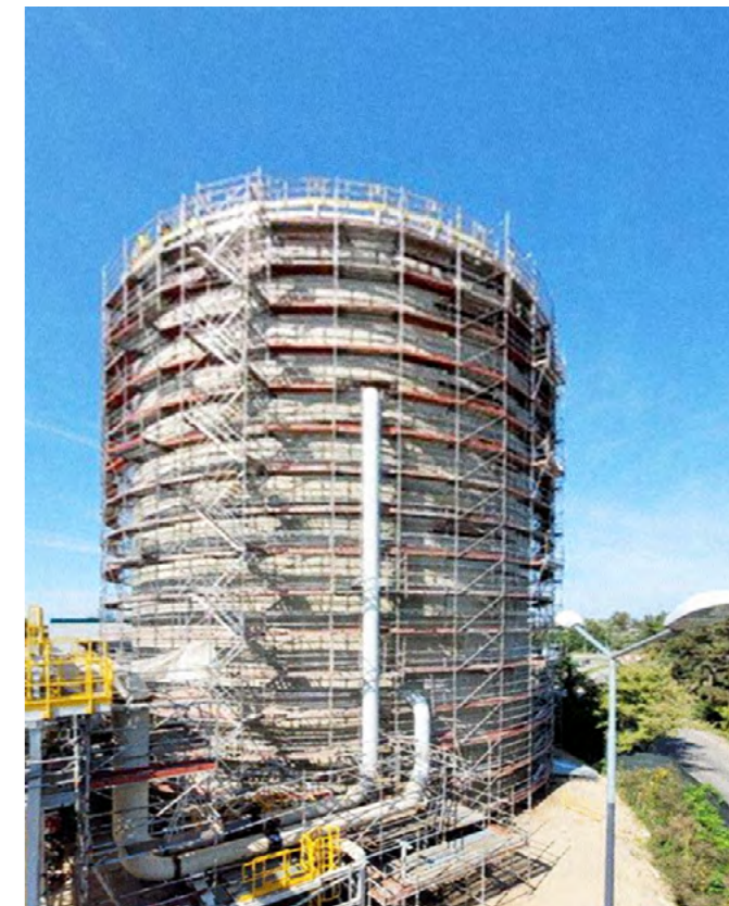
— Akumulator ciepła, fot. PGE Energia Ciepła, KOGENERACJA SA.
