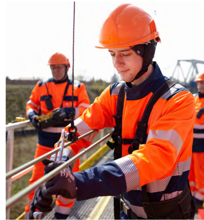
Brygada elektromonterów w terenie (fot. archiwum PGE Energetyka Kolejowa).
