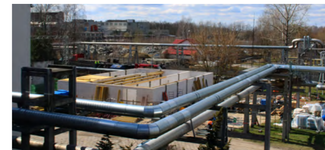
Budowa podstacji sprężeniowej 110/15kV w Zgierzu.
