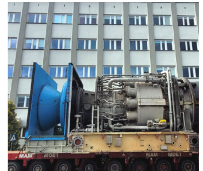
Modernizacja turbiny gazowej w elektrociepłowni w Zielonej Górze.
