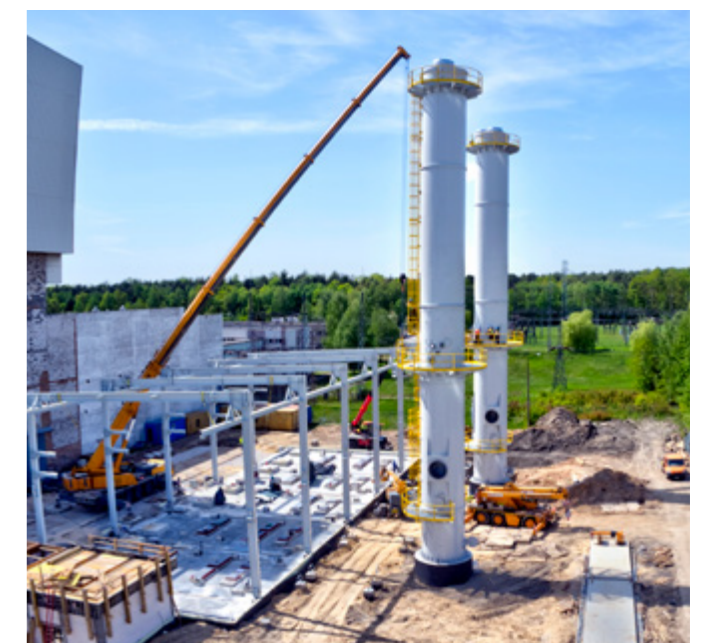
Niskoemisyjne źródła ciepła i energii powstają m.in. w kieleckiej elektrociepłowni.
