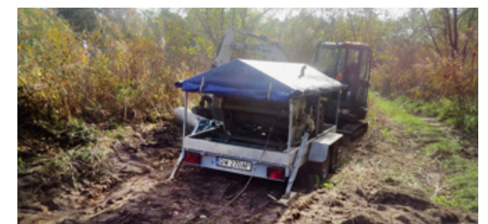
— Energetycy prowadzą nowe sieci kablowe m.in. przez tereny leśne.
