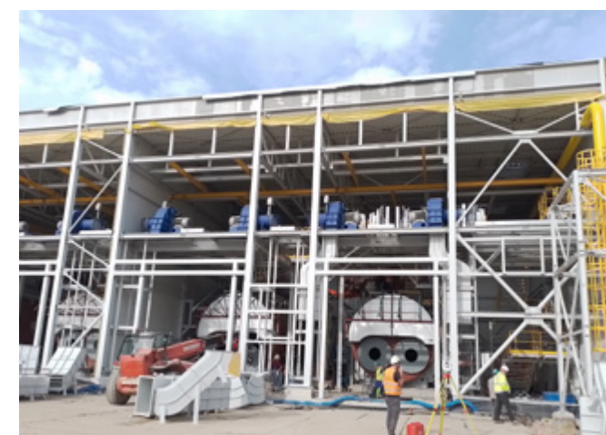
— Montaż kotłów w kotłowni szczytowo-rezerwowej.
