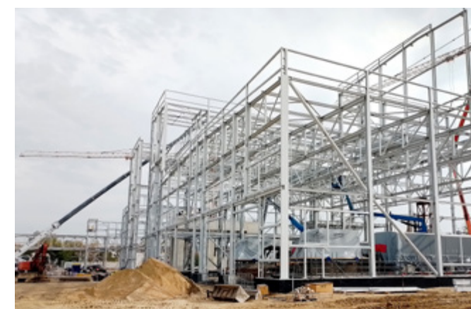
— Konstrukcja budynku głównego z turbinami i generatorami wprowadzonymi na swoje fundamenty.
