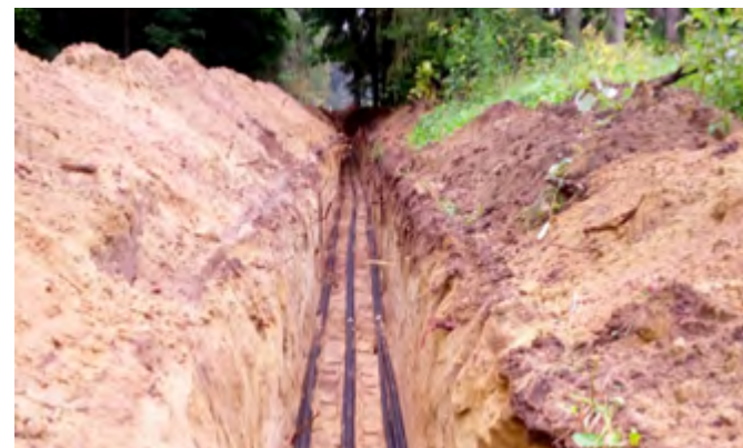
W Etłku linie kablowe SN zastąpiły wyeksploatowane linie napowietrzne.
