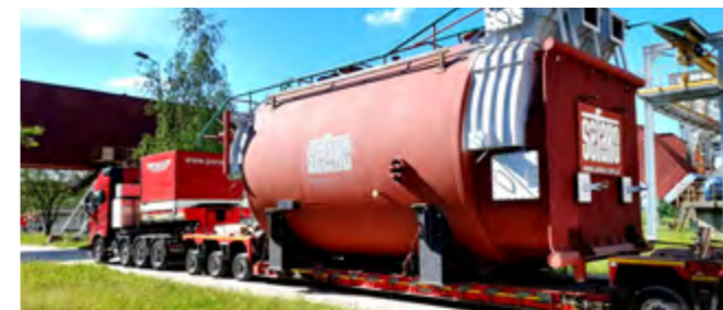
W kieleckiej elektrociepłowni zakończył się już montaż kotłów wodnych gazowych.
